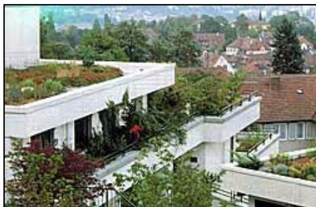
Complesso residenziale «Tazzelwurm»: verde intensivo ed estensivo. Realizzazione 1979/1984. Superficie 1.480 m 2
