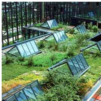
Cassa di risparmio di Monaco (Stadtsparkasse Munchen). Superficie di giardini pensili 5.000 m 2 , realizzazione 1987/88
